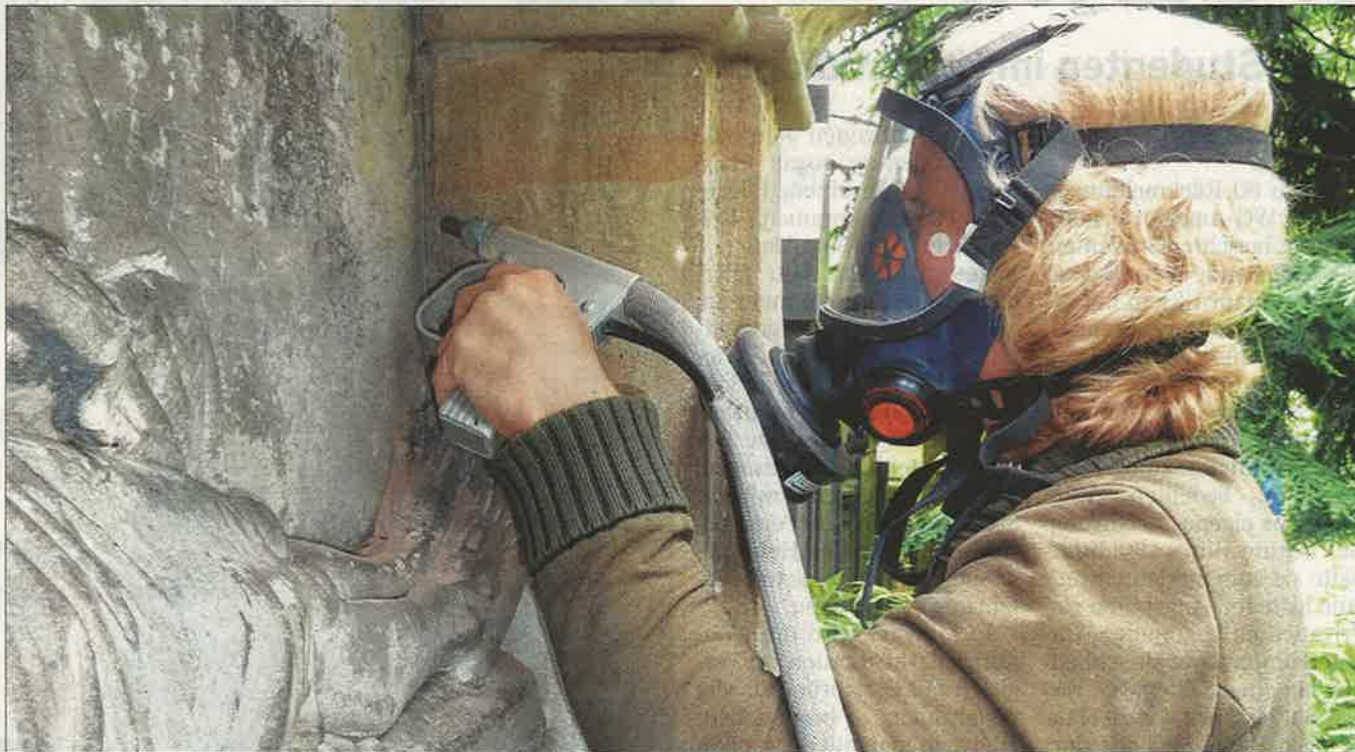
Restauratorin Inga Probst reinigt das Grabmal der Familie Schroeder. Das hätten auch andere Gräber nötig.
